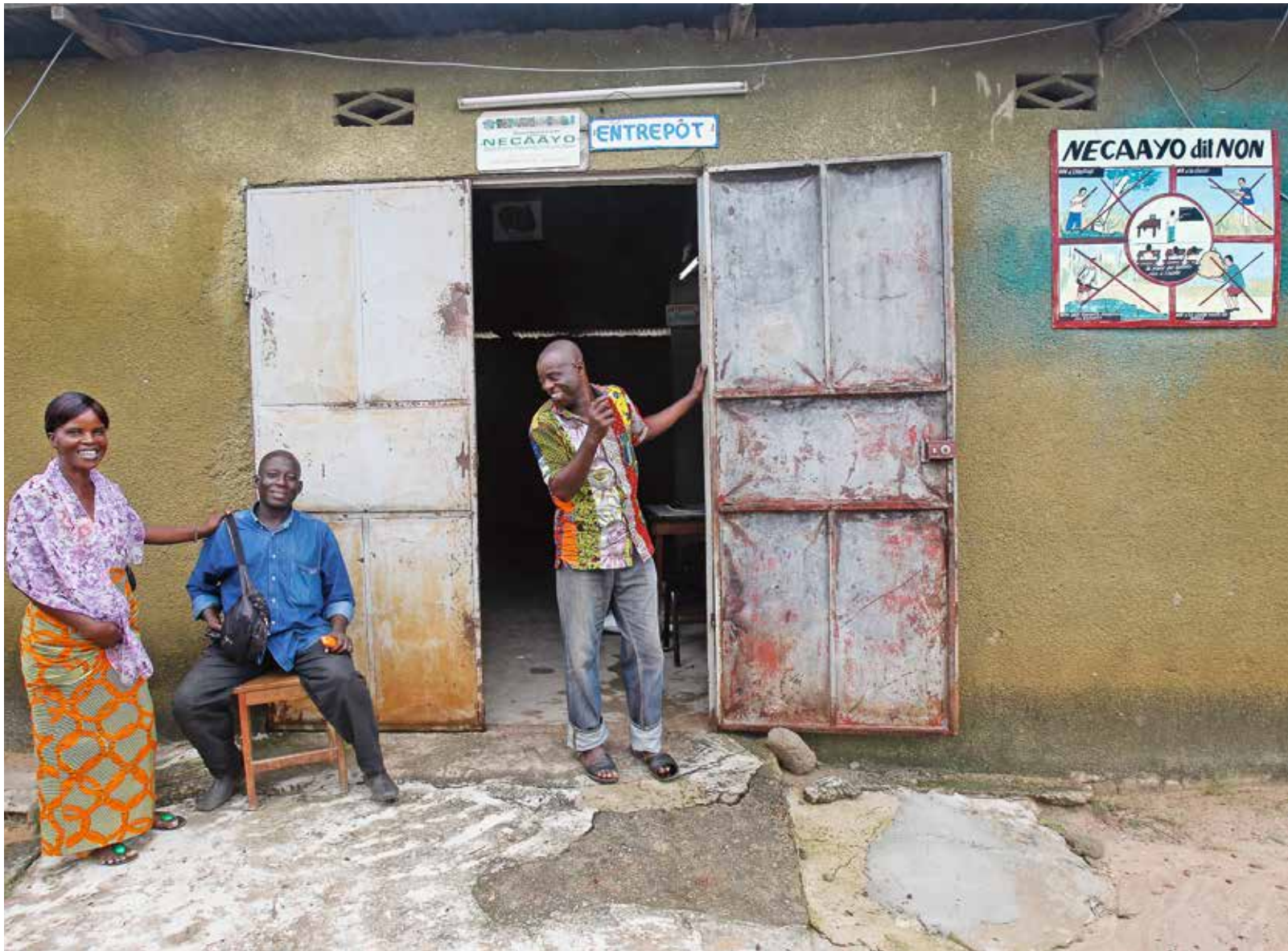
Ein Materialdepot in der Kakaokooperative Necaayo: Dank der UTZ-Prämien konnte der Bau von Lagern zum Schutz vor Feuchtigkeit realisiert werden.
